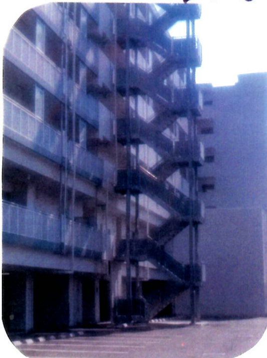
写真3 津波避難階段
