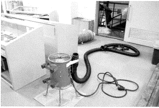
機械類の設置
