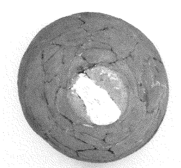
底部 修復前の状況
