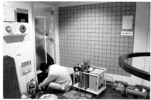
機械類の設置
