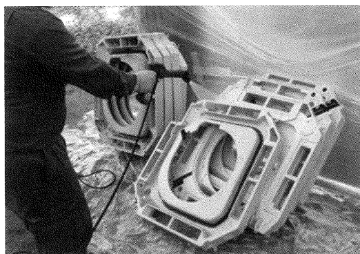
エアコン部品の洗浄作業
