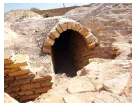
神学校の屋根に設置された通風口
