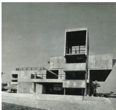
食堂が入っていた当時の福利厚生棟
