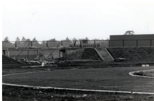
第6図 建設中の陸上競技場
