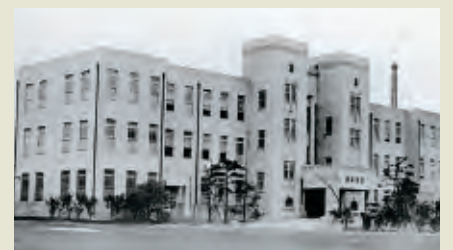
(写真2) 竣工当時の旧1号館
